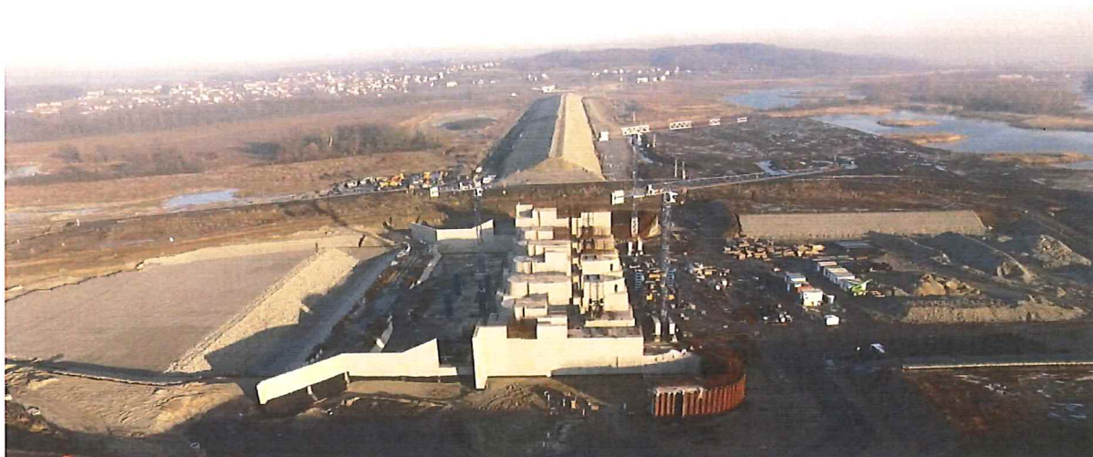
Fot 1. Widok na budowlę przelewowo – spustową, sztuczny wybój, kanał doprowadzający oraz nasyp korpusu zapory czołowej.
